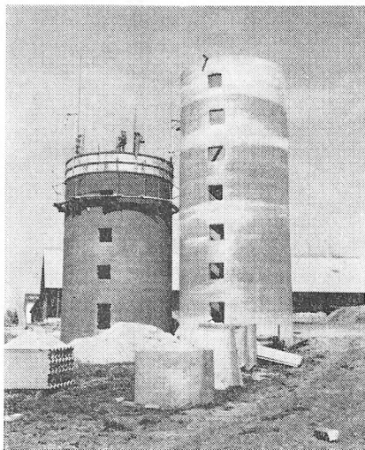
Fig. 10. Støbning af tårnsiloer i glideforskalling.
