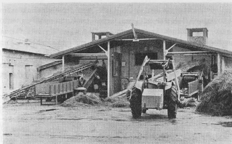
Fig. 2. Fra en dansk lucernegrønmelsfabrik. Forsiden af tørreriet med de tekniske installationer, som fører lucernen til tørreanlæggene.
