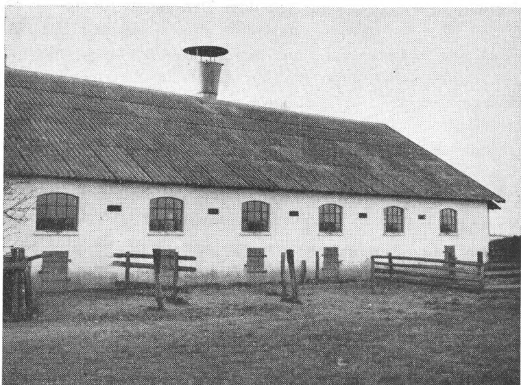
Fig. 4. På denne staldlænge ses tydeligt indsugningsventilerne og skorstenshætten.
