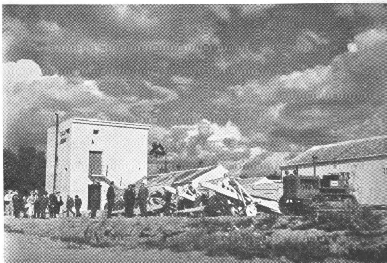
Fig. 8. En maskinstation i et udstykningsområde ved bredden af Guadalquivir.
