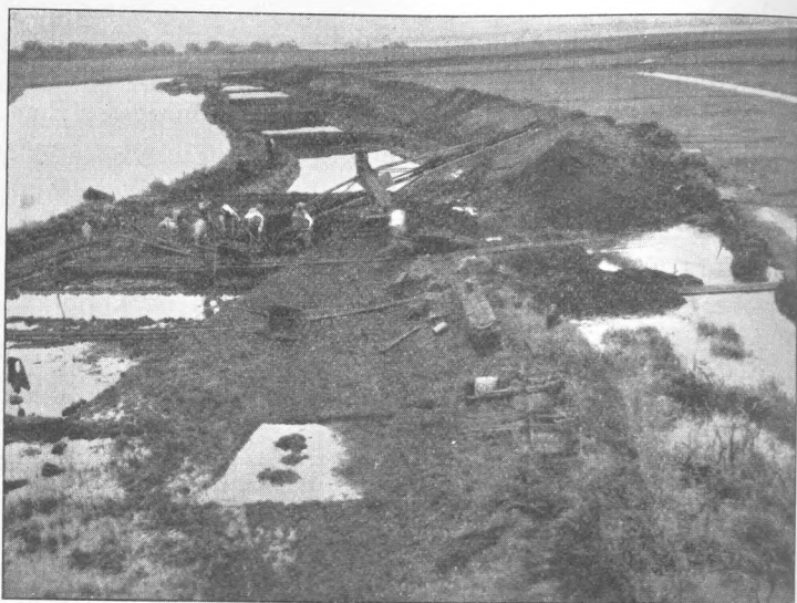
Fig. 5. Bygning af et Dige langs Vejle Aa.
