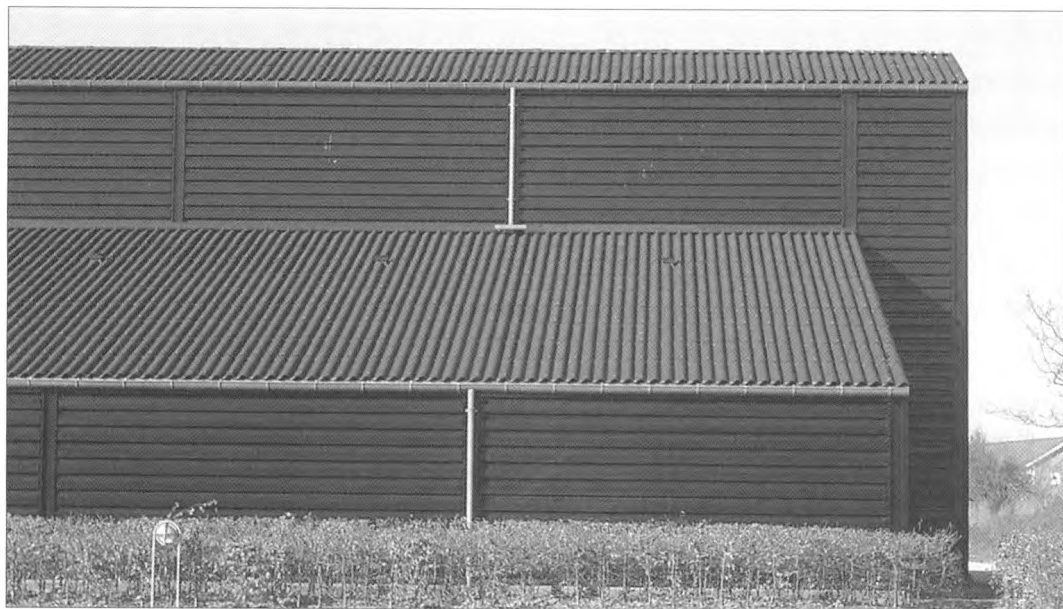
En enkel, lukket og sammensat bygningskrop. Coloplast, Humlebæk
