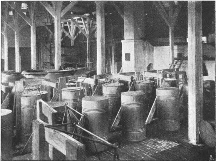
Fig. 3. Inddampning og Pakrummet for Kalksalpeter ved Notoddens Kvælstoffabrik.
