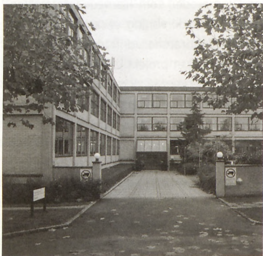
Figur 4. Plantedirektoratet, Sorgenfri. Blev bygget som administrations- og laboratoriebygning for Statsfrøkontrollen i 1970. Den var på det tidspunkt en af de største og mest moderne frøkontrolstationer i verden. Da antallet af prøver blev reduceret, blev en del af laboratoriefaciliteterne anvendt til undervisning af danske og udenlandske studerende.
