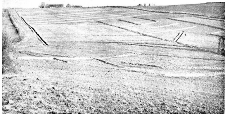
Fig. 3. Dræning under Udførelse.
