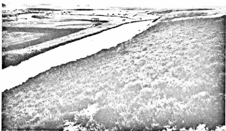
Fig. 2. Vandingskanal til Overrisling af Hede.
