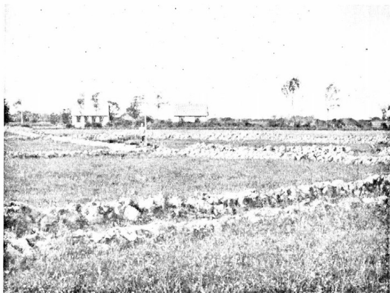
Fig. 4. Dræning under Udførelse.
