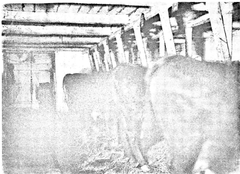
Fig. 14. En gammel Stald, hvor der tidligere i Rækken stod 12 Køer med sædvanlig Stadelplads (ca. 95 cm), men hvor Ejeren nu har indrettet til 9 Køer og med Adskillelse mellem hver Ko. Spiltogets bageste Stolpe gaar til Loftet, hvilket jo i høj Grad præger Staldens Udseende og Udsynet over Køerne.
