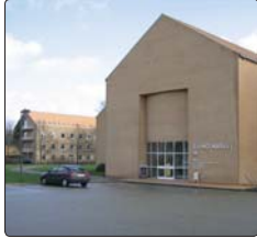
Planerne om at bygge det såkaldte Inspiratorium under glassplanen øst for museet er udsat på ubestemt tid. Men det er stadig tænkt, at bygning 110 bygges til venstre skal huse medarbejderne fra Steno Institutet, som i forbindelse med omorganiseringen har skiftet navn til Institut for Videnskabsstudier. (Foto: Hanne Teghns)
