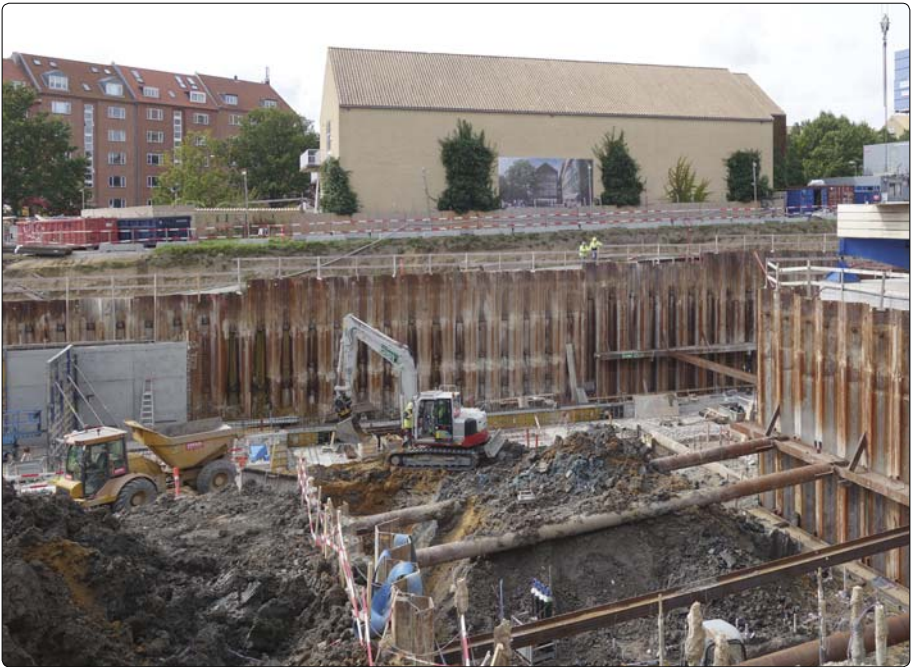
Hullet er ikke langt fra Steno Museet, så der skal solid afstivning til for at begrænse risikoen for sætningskader m.v. Foto: Hans Buhl.
