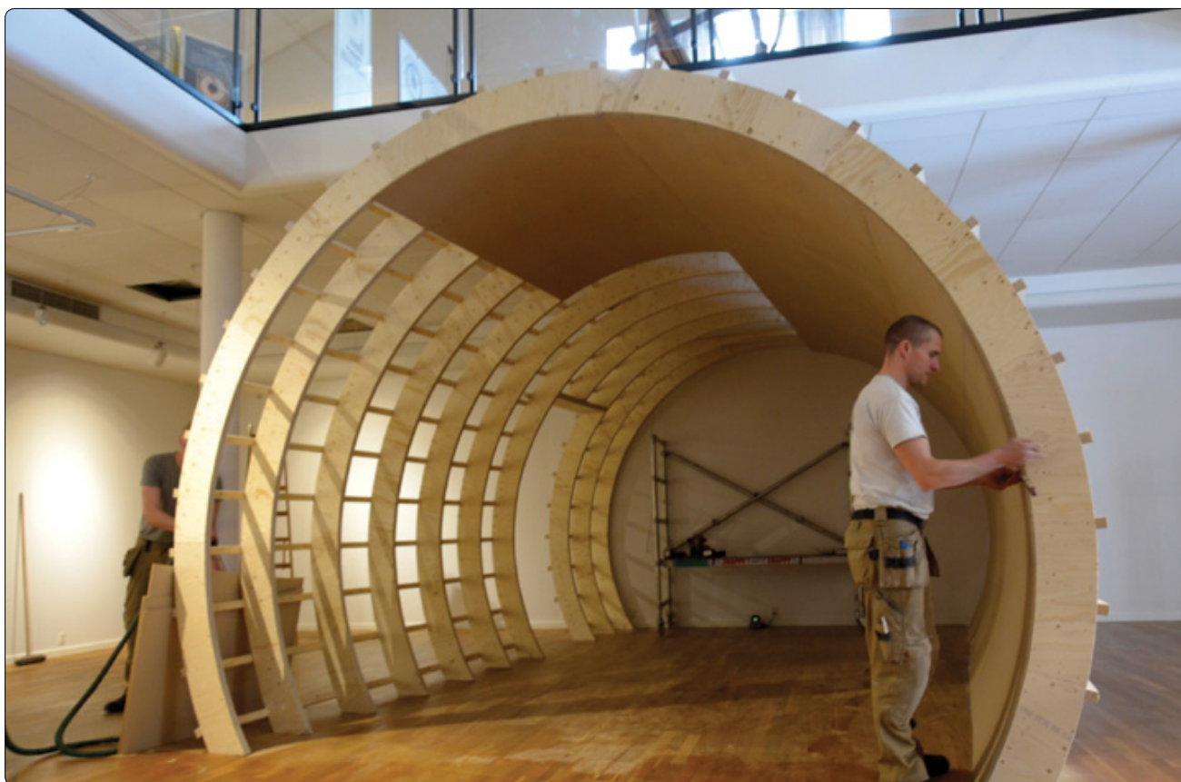
Rekonstruktionen af tunnelstykket til LEP-acceleratoren var noget af det første, der blev bygget til den nye udstilling. Foto: Erik Balle.
