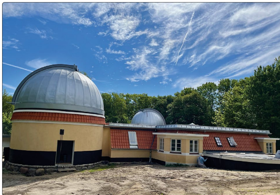
Håndværkerne er efterhånden ved at være færdige med den omfattende restaurering af det gamle observatorium i Højbjerg. Den nye kikkert skal placeres i den store kuppel til venstre. Foto: Charlotte Trolle Olsen.
