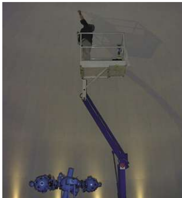
Reparation af kuppelplader. (Foto: Ole J. Knudsen.)
