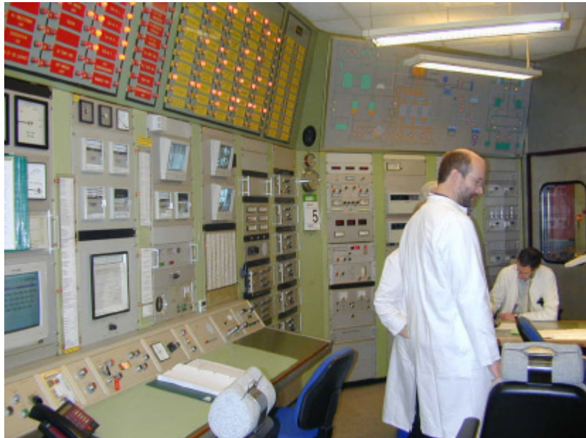
Inspektion af DR3's kontrolrum. (Foto: Hanne Tegllhus)
