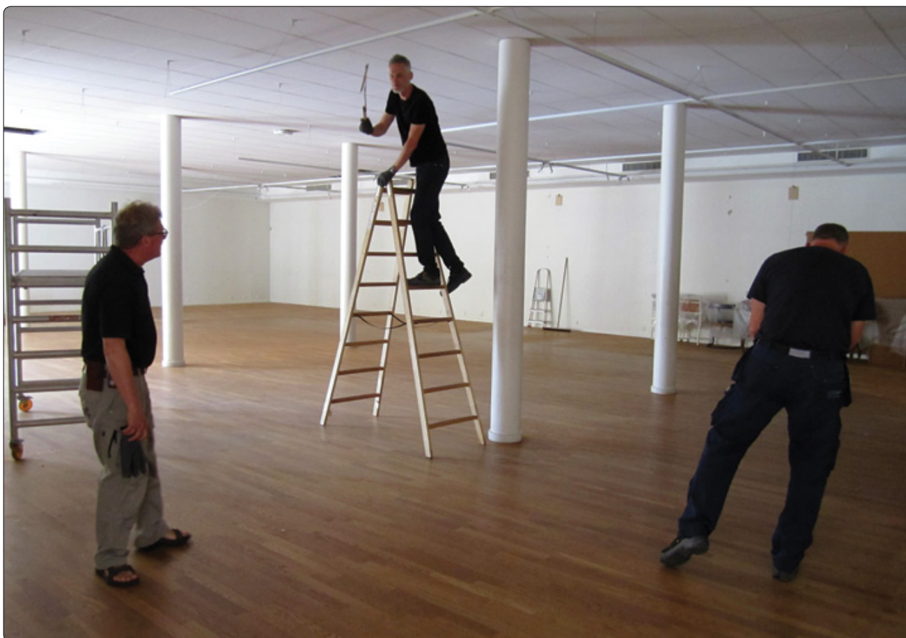
Værkstedsmedarbejderne Lasse og Niels samt elektriker Dennis in action i det tomme rum. Foto: Mary Marie Kromann.
