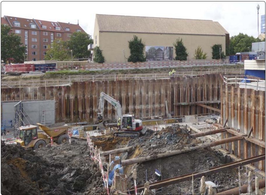
Hullet er ikke langt fra Steno Museet, så der skal solid afstivning til for at begrænse risikoen for sætningskader m.v. Foto: Hans Buhl.
