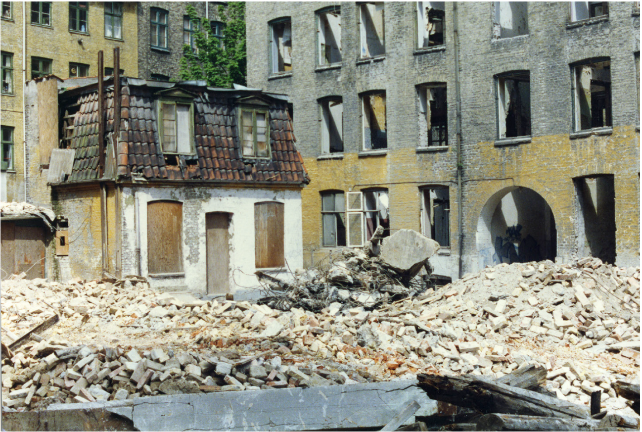
Baggård i Absalonsgade under nedbrydelse, 1993.
