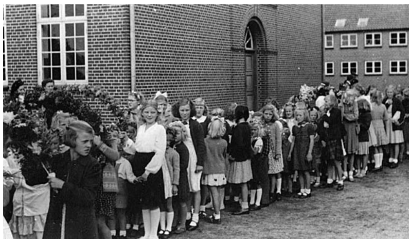
Også i Tønder Amt blev der bygget nye skoler. Øverst Abild Skole, indviet den 25. november 1943. Den nye skolebygning var så rummelig, at der ud over gymnastiksal og sløjdlokale også var plads til lærerindebolig og kommunekontor. Nederst Møgeltønder Skole, som fik en ny tilbygning i 1942 med faglokaler og skolebibliotek. Billedet stammer fra 1949, hvor en ny skolefane blev indviet. Foto: Tønder Lokallhistoriske Arkiv.
