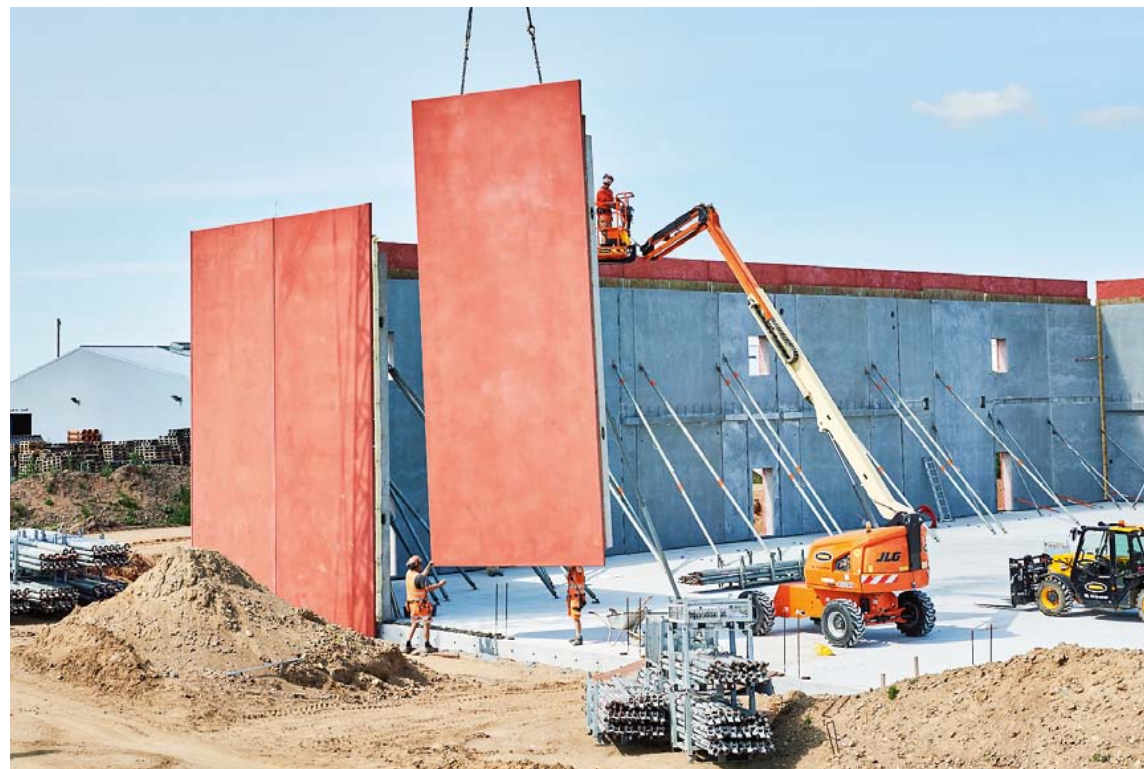
Opførelsen af Bevaringscenter Sønderjylland holdt fuld fart i 2020 og var begunstiget af godt vejr. Heller ikke corona påvirkede byggeriet. Her rejses de store, indfarvede betonelementer, der udgør ydervæggene i magasindelen. Foto: Fl. Wedell.
