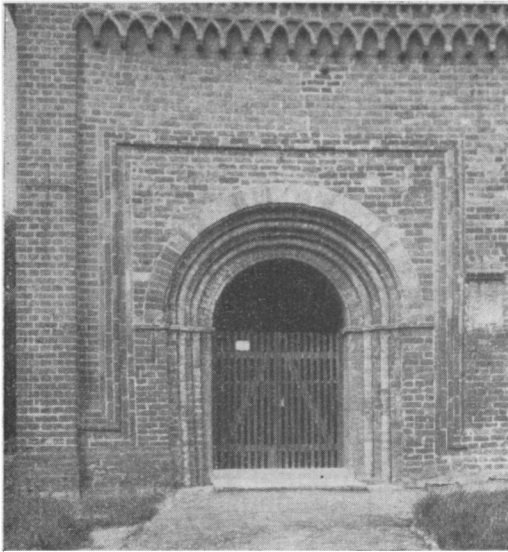
Fig. 5. Domkirken i Ratzeburg. Forhallens Portal.
