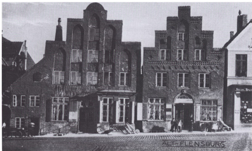
Flere af de største oksehændlere boede i de solide stenhuse rundt om Søndertorv i Flensborg. Her boede således Merten Risenberg, Wilhelm Vinberg og klokkestøber Peter Hansen, som forenede støberiet med okse- og hestehandel. Disse to nu nedrevne gavlhuse er typiske for bebyggelsen omkring år 1500. Huset til venstre (nr. 8) ejedes omkring 1500 af Peter Partzow, præst ved Skt. Nikolai kirke. Dansk Centralbibliotek for Sydslesvig.
