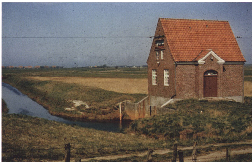
Reguleret og inddiget åløb med pumpestation i Tøndermarsken efter afvandingen i 1920'erne. Bemærk strømforbindelsen til Sønderjyllands Højspændingsværk i Aabenraa. H.P. Hanssen foreslog, at strømmen blev købt her i stedet for at oprette et vandkraftværk. Foto: Museum Sønderjylland – ISL.
