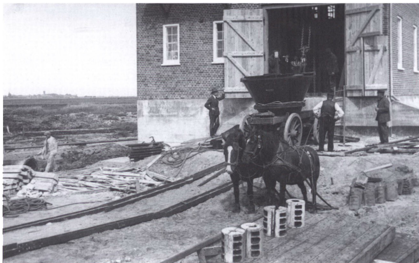
Elektrisk pumpe på vej ind i Lægan Pumpestation. Ca. 1928/29. Foto: Tønder Lokallhistoriske Arkiv.
