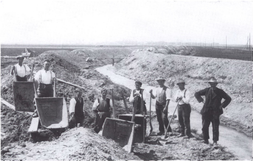
Arbejdssjak i færd med grøftegravning i marsken ca. 1925. Foto: Tønder Lokalhistoriske Arkiv.
