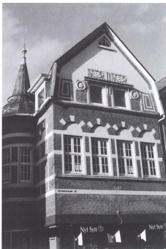
Tønder. Nutidigt foto af den tidligere »Nordschleswiger Bank« Storegade 21, bygget 1904 af Jürgensen og Bachmann, Berlin (stueetagen ændret).
