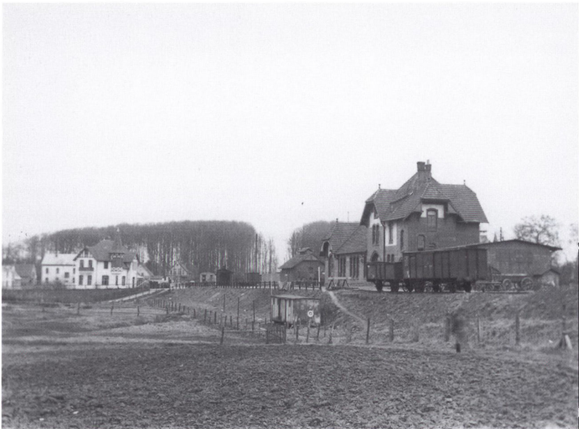
Banegårdsarealet i Gråsten o. 1910. Til højre statsbanegården, hvor der fra 1901 var fællesekspedition for stats- og kredsbanen, indtil kredsbanen opførte sin egen stationsbygning i 1907. Den ses til venstre i billedet. I baggrunden den nu forsvundne Stængerodde skov, hvor banernes af hertugen omstridte gennemskæring tydeligt ses mellem de to stationsbygninger. Det fremgår, hvorledes banerne er anlagt på en dæmning henover et lavtliggende areal. Også udsigten fra Gråsten by, som ligger t.v. udenfor billedet, blev påvirket af jernbanernes komme. Foto: Gråsten kommunes lokalhistoriske arkiv.
