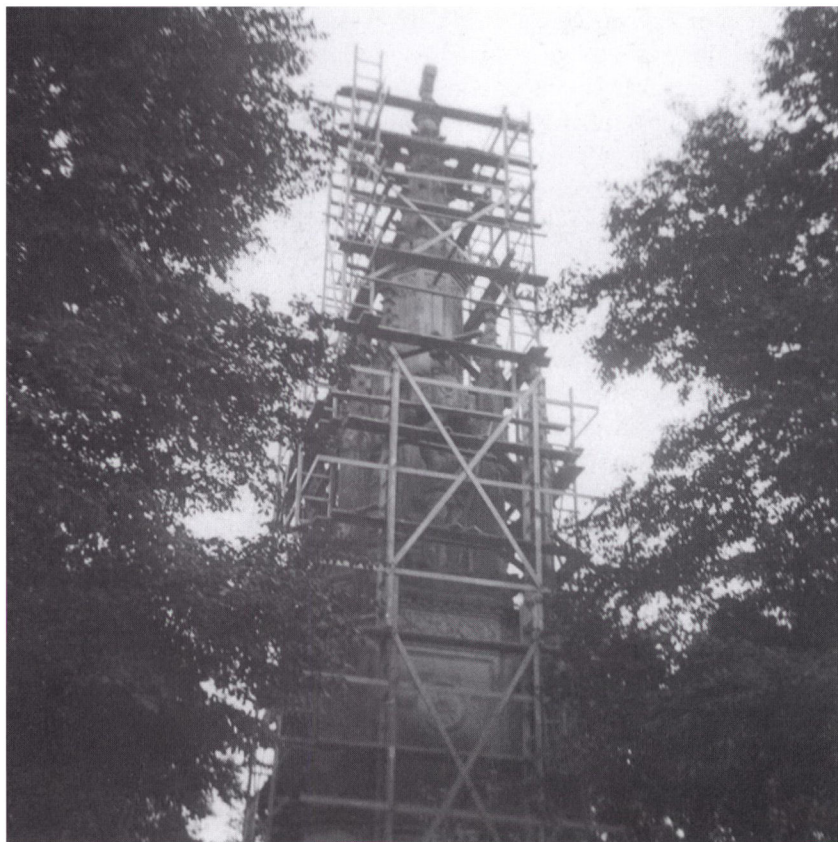
Arntkiel Denkmal under restaurering 1939. De to sejrsmonumenter blev pakket ind i stilladser fra firmaet Wasa A/S, København. Højden på Düppel og Arntkiel Denkmal angives ofte til henholdsvis 22 og 18 meter. Det var formentlig også disse højder, der blev opgivet til stilladsfirmaet. Under opbygningen af stilladset viste det sig imidlertid, at monumenterne var henholdsvis 24 og 20 meter. Det gjorde restaureringen en del dyrere end budgetteret. Foto: Rigsarkivet: SM 3/1946.
