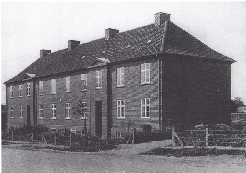
Padborg By. Et af de mange byggerier, der blev opført i den nye Nørregade i Padborg for at skaffe et større antal tjeneste- og lejeboliger til statsbanernes medarbejdere. Opført på de supplerende eksproprierede arealer, hvorom den juridiske kamp blev udkæmpet. Foto i Jernbanemuseet.
