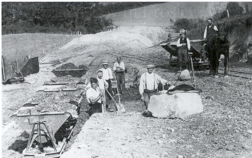
Det var hårdt arbejde at anlægge vej i 1920'erne. Foto fra anlæg af Varnæs-vejen. Foto i Ensted sogns lokalhistoriske arkiv.
