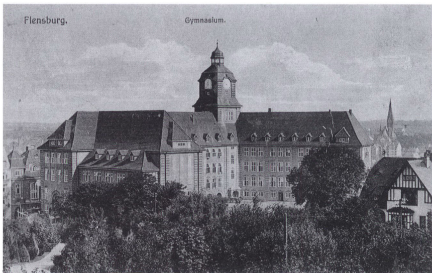
»Altes Gymnasium« i Flensborg fik nye bygninger i årene 1912-14. Det imponerende skolekompleks var næppe færdigt, da de danske sønderjyder blev indsat her i august 1914. Bygningen blev på den måde indviet af de danske fanger. Skolen er gengivet efter et postkort 1914. Dansk Centralbibliotek for Sydslesvig.
