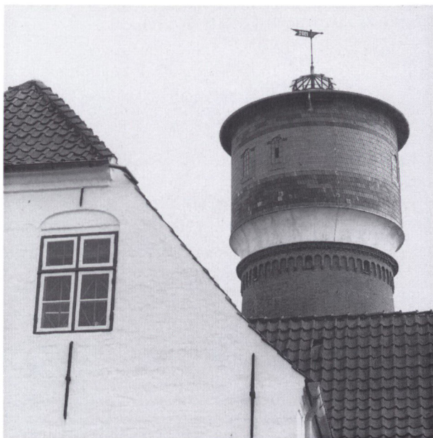
Kig over Tønder Museums tage til toppen af vandtårnet, hvis herlighedsværdi indgår som et væsentligt element i de planer, som Museerne i Tønder har for fremtiden. Foto: Planetfoto.
