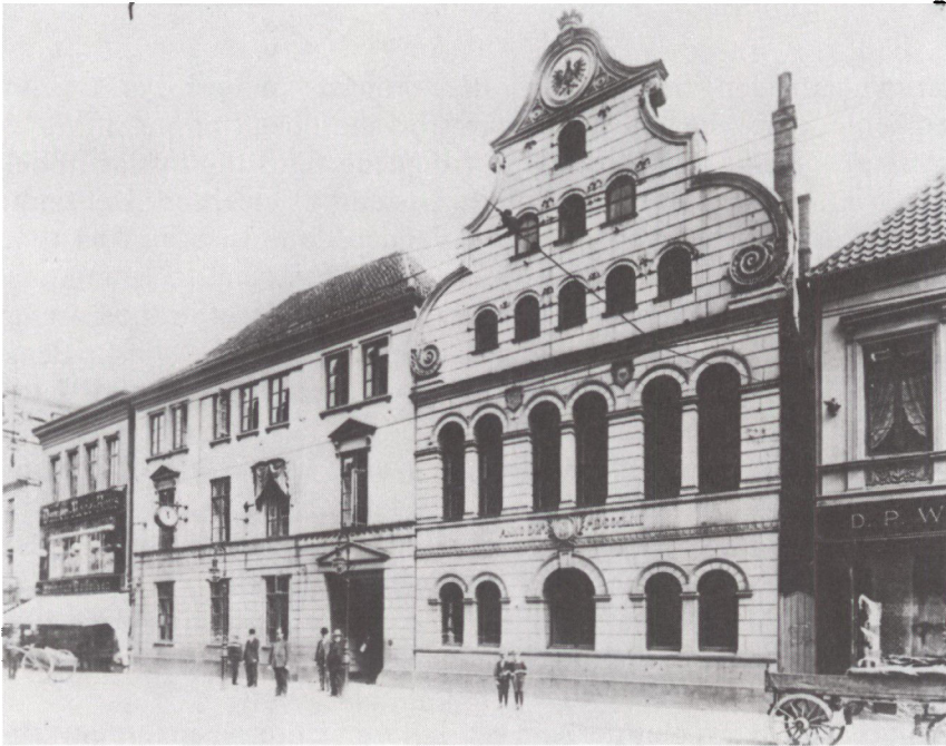
Regeringsbygningens todelte facade mod Holmen. I det klassicistiske hus til venstre blev der indrettet en gæstebolig til kongen. Bag de tre dobbeltbuer på første sal i det barokke gavlhus lå retssalen med L. Frølichs store malerier. Billedet er taget, efter at det danske rigsvåben var blevet udskiftet med den preussiske ørn. (Flensborg Byarkiv)
