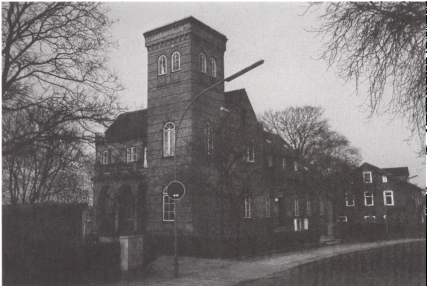
Hargens hus (Lutherhaus), den bedst bevarede af Winstrups bygninger. Her ses tårnet, der knytter sig til den to-etagers bygning som en italiensk campanile til sit kirkeskib. I fortsættelse af tårnet ligger arkaden med en balkon på toppen. (Foto: Hans Munk Hansen)
