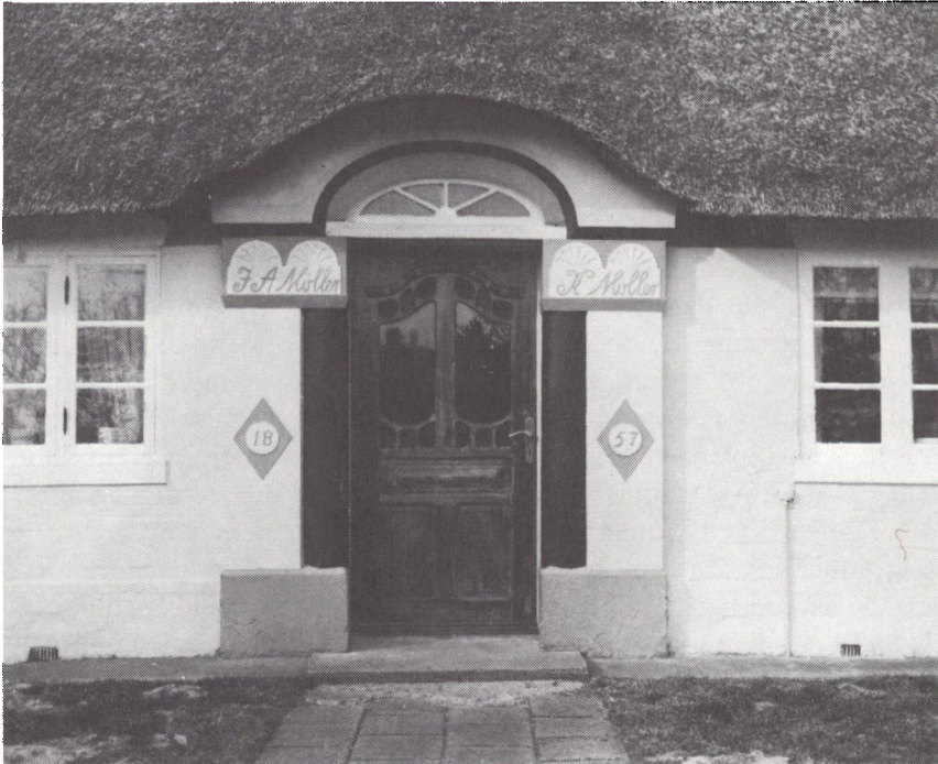
Portal og indgangsdør til matr. nr. 44 Kongsmark.
