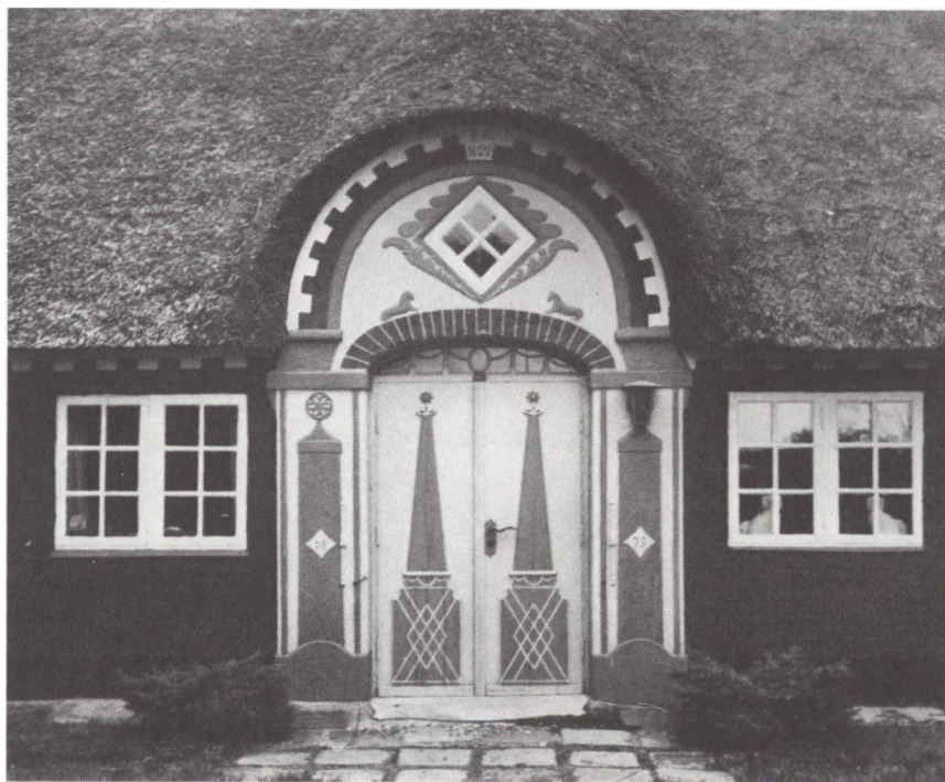
Portal og indgangsdør fra matr. nr. 32 Kongsmark.
