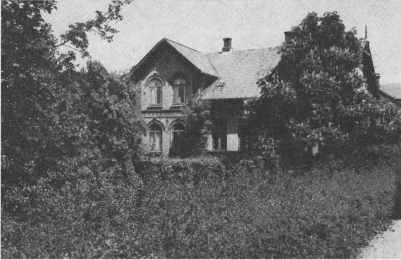
Haderslevvej 23, bygget 1896 af C. Iversen.
