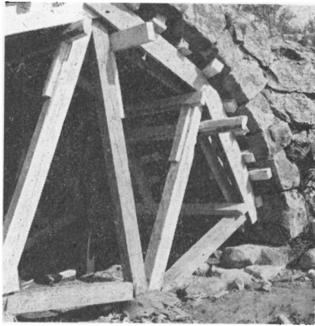
Restaureringen af Povlsbro, foto Aaman Sørensen.
