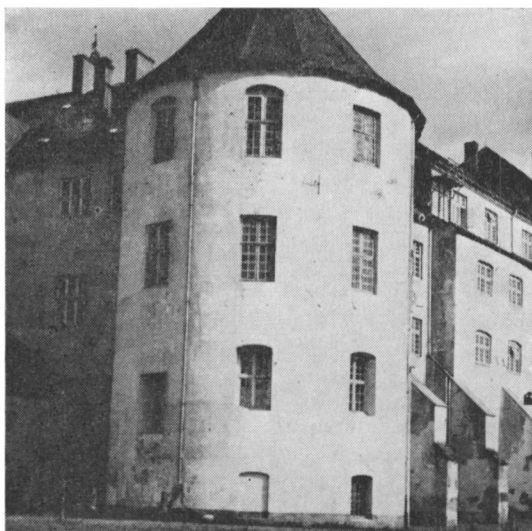
Det kraftige, runde tårn, hvor vestfløjen mødes med nordfløjen.
