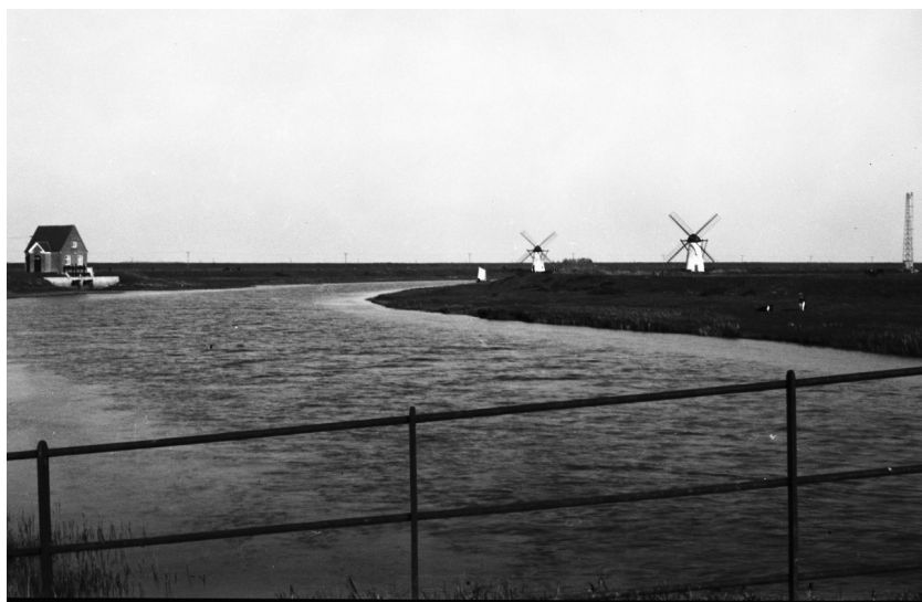
Vidåen ved Ny Frederikskog syd for Højer mellem fortid og fremtid: til højre ses de gamle pumpemøller. Til venstre ses den nyopførte Højer Pumpestation. 1929. Foto: Lokalhistorisk Arkiv for Gl. Tønder Kommune.
