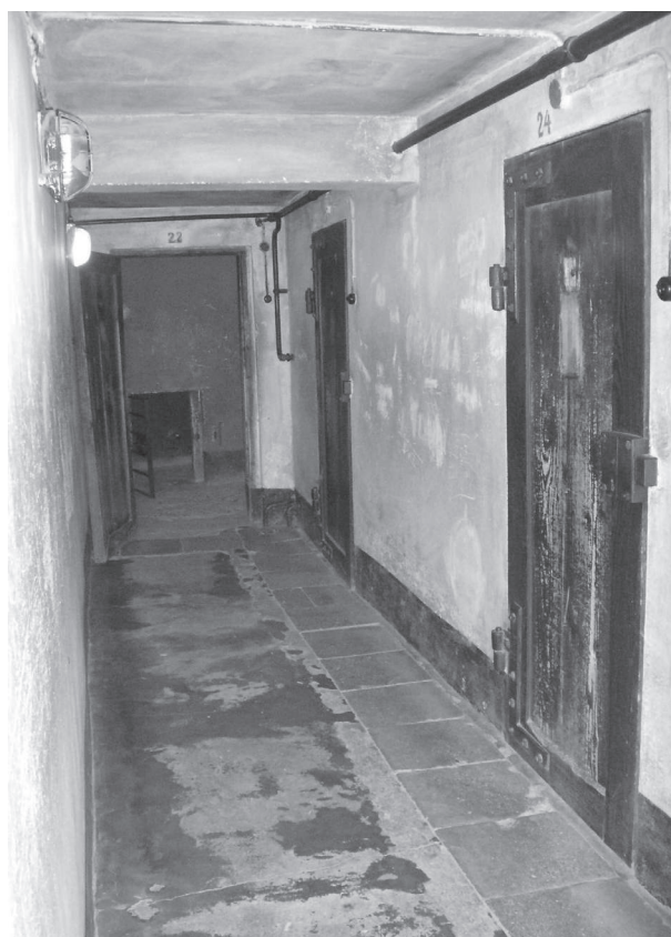
Celler i kælderen i blok 11.
