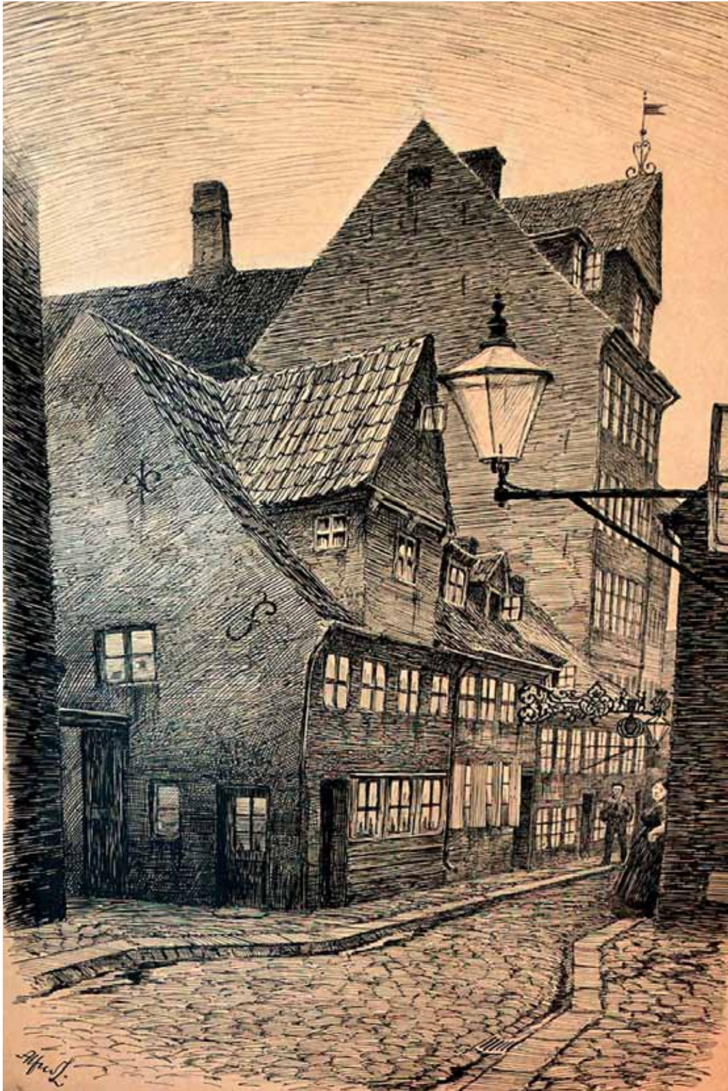
Henriette Pätges' værtshus i Ulkegade. Tuschtegnning af Alfred V. Larsen, 1930.
