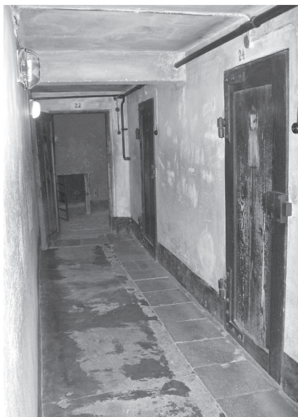
Celler i kælderen i blok 11.
