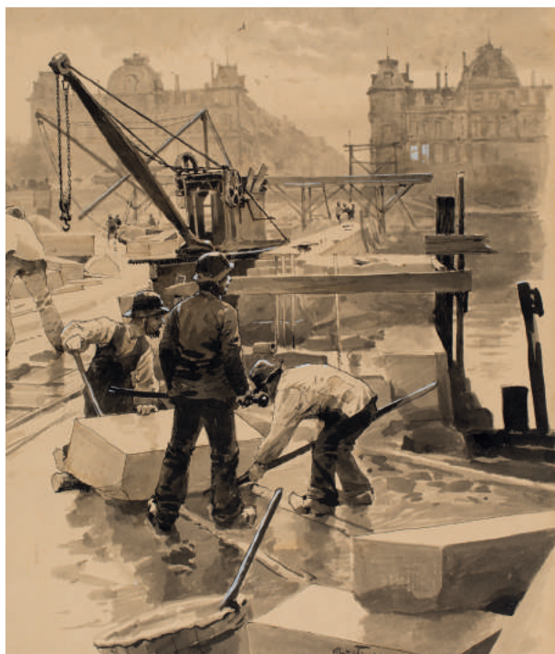
Dronning Louises Bro under Opførelse, 1886. Københavns Museum.
