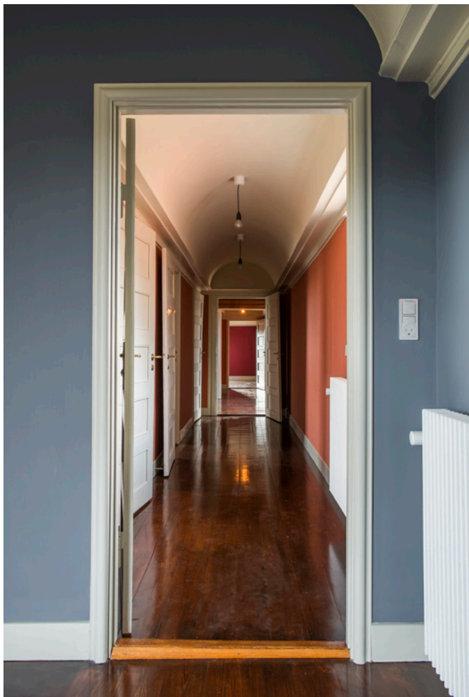
[7] I 2016 afsluttede Realdania By & Byg en restaurering af et landsted fra 1918, tegnet af arkitekten Kay Fisker med vægt på at genskabe de oprindelige farver og overflader. Dagslyset reflekteres på bræddegulvenes skinnende lak og i dørindfatningens blanke linolie, mens de silkebløde limfarvede vægge står matte. Foto: Realdania By & Byg / Kurt Rodahl Hoppe.
