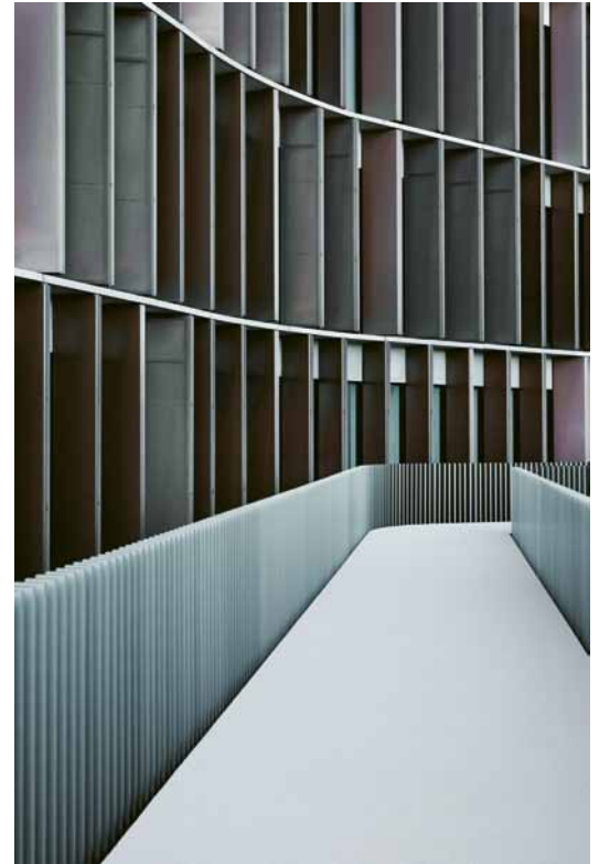
[5] Mærsk Tårnets karakteristiske kobberfacade er baggrunden for tildelingen af Copper in Architecture Award, som tildeles af The European Copper Institute. Ligeledes har et andet delaspekt, bygningens grønne tage, resulteret i tildelingen af Scandinavian Green Roof Award. Foto: Nikolaj Rentzmann.
