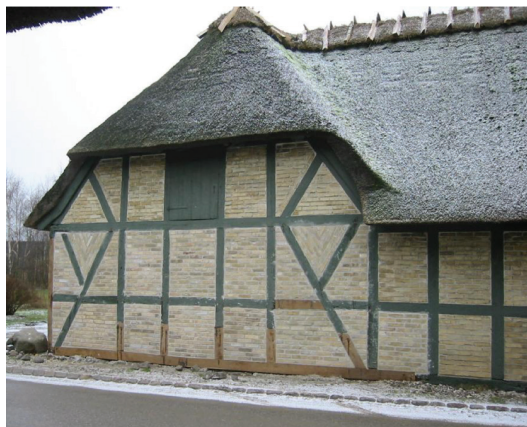
Figur 6. Bindingsværksmur med tavl af ukalkede brændte sten. Kilde: www.bygningsbevaring.dk
