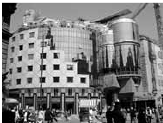
Hans Holleins Haas Haus . Stephansdom genspejles i glasfacaden.
