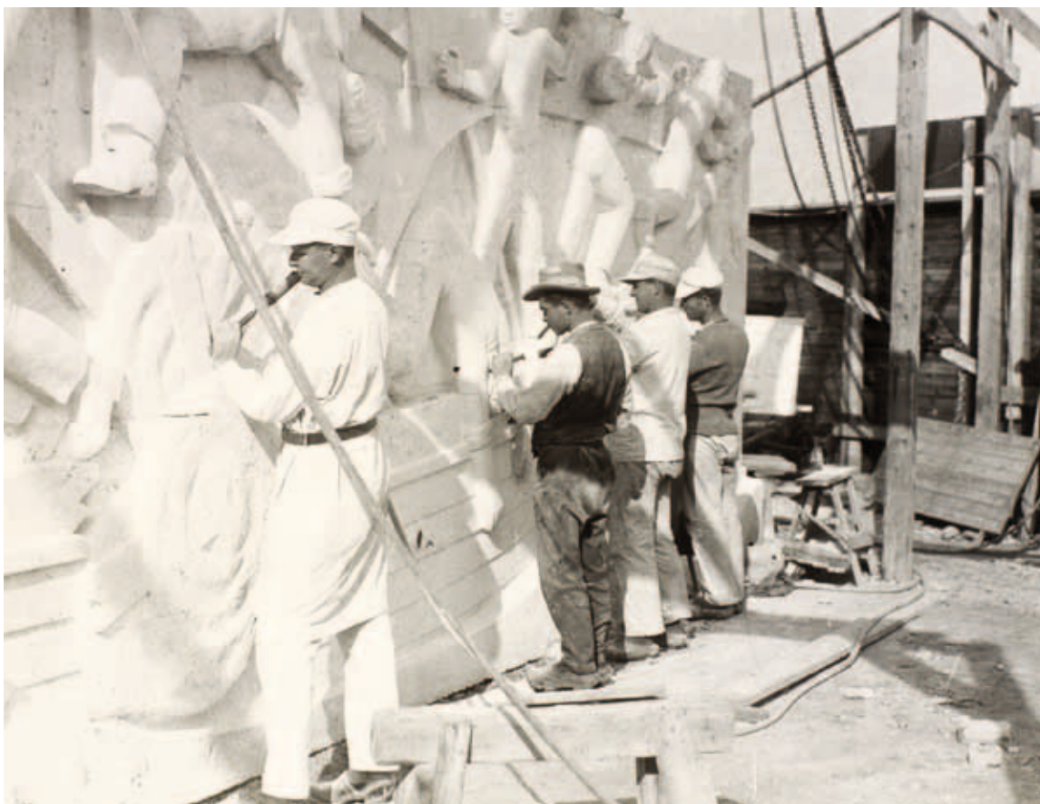
Fig. 10. Svend Rathsack arbejder sammen med tre stenhuggere på det sydøstlige relief. (Ca. 1925-26). Danmarks Kunstbibliotek, kasse 325, 132.
