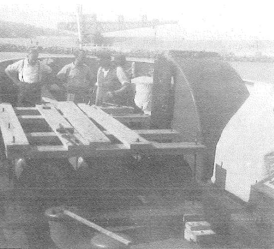
Konstruktion af en redningsflåde på GEIRs agterdæk.
