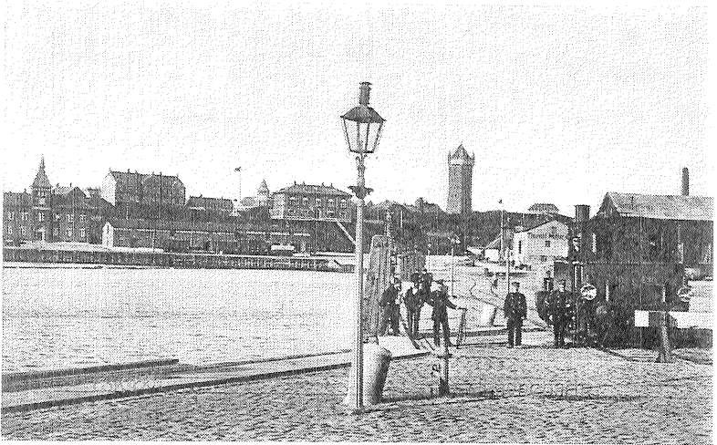
Parti af Dokhavnen i Esbjerg 1902. T. h. vandtårnet og yderst t. v. toldkammerbygningen, begge opført 1897. – Efter gl. prospektkort.
