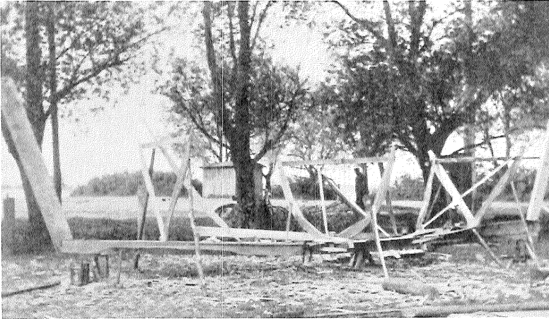
Bau eines Fischerbootes in Westpreußen mittels Mittelspant und zwei Richtspanten. – Foto W. Empacher, Eberbach am Neckar.
